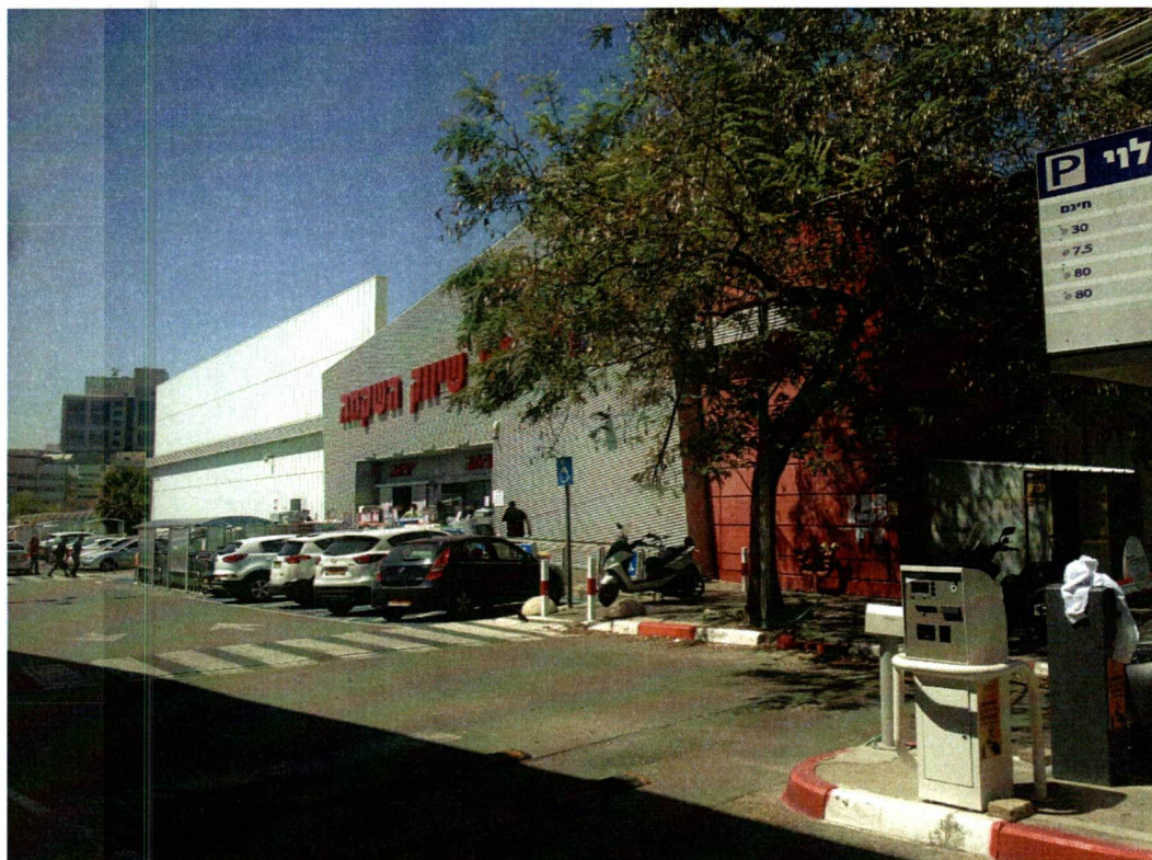
איור 23 : מבנה הסופר מרקט - מבט מתוך המתחם
