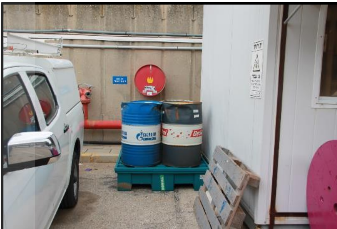
תמונה מספר 15-1.6.13: חביות שמנים על מאצרת פלסטיק
