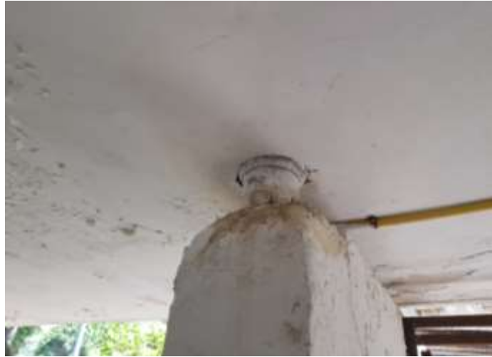
תמונה 23 צינור בויב עשוי מאסבסט צמנט בקולונדה של מבנה קליבלנד 14
